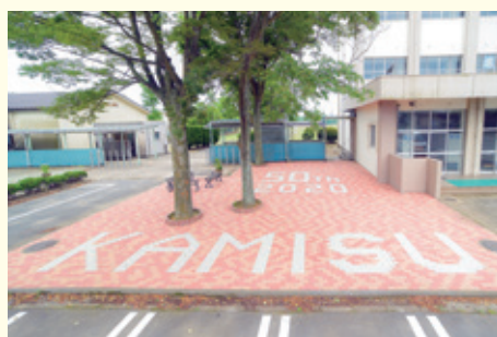
インターロッキング
